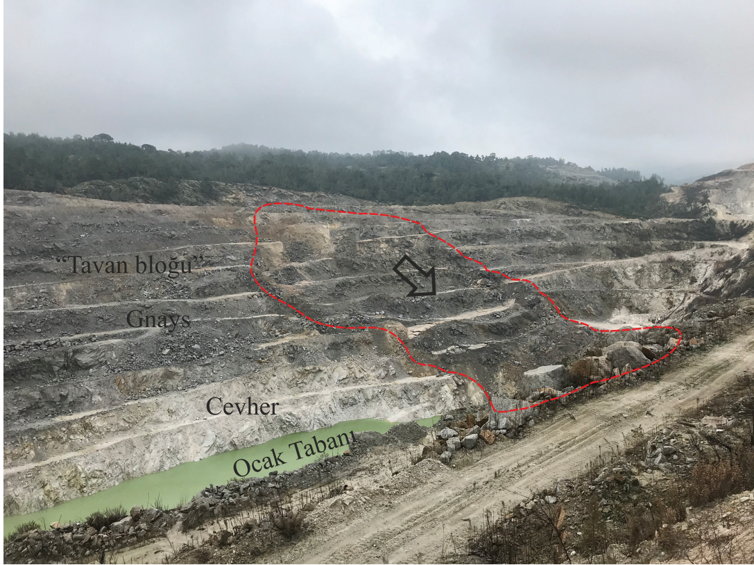
Şekil 11. Kayma yüzeyinin şev topuğunda gnaysı kesmesi (cevheri kıramamıştır).
